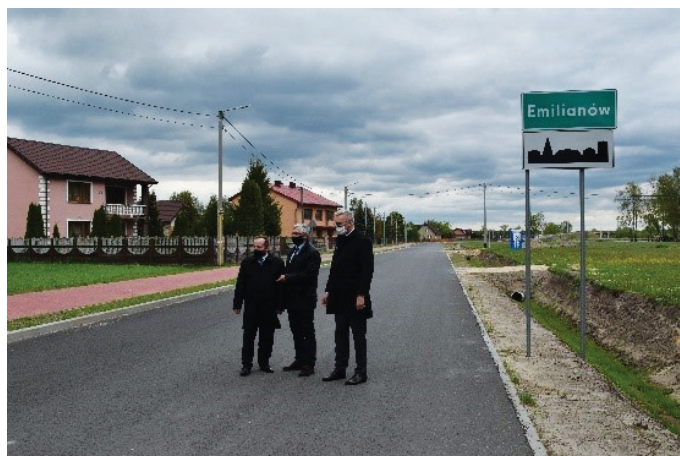
▲ Fot. 21 Rozbudowa drogi na odcinku Wola Rasztowska -Zwierzyniec
