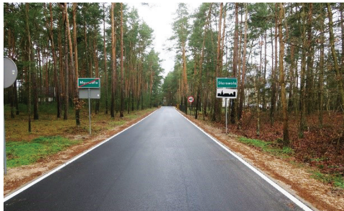
▲ Fot. 20 Wykonanie nakładki w msc. Starowola
